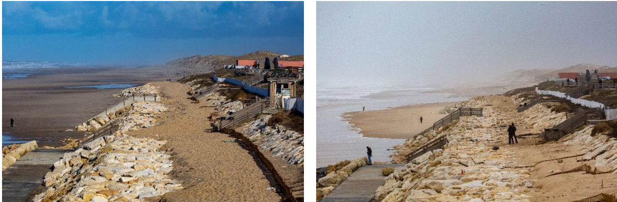
Figure 16. Lacanau : Comparatif de l'ouvrage entre le 28/01 (gauche) et le 01/02 (droite). © Ville de Lacanau
