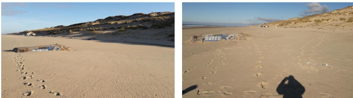
Figure 20 – Blockhaus du Lion au sud de Lacanau-Océan le 10/11/2022 (photo de gauche) et le 30/11/2022 (photo de droite). © OCNA
